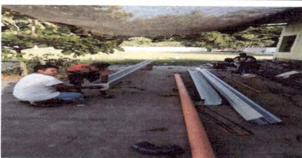
Foto 5: CANALES Y BAJADAS DE AGUA PLUVIALES: Sustitución de canal de aguas pluviales de 2 aulas de PVC 18ML
