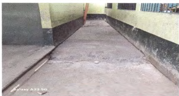
Foto 7: Losa de patio: Reparación de plancha de concreto de patio 15m2 módulo 1 de aulas.
