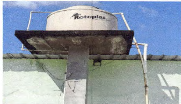
Foto 8: Mantenimiento de cisterna y depósitos de agua: sustitución de depósito de agua 1700 lt.
