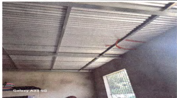
Foto 1: CUBIERTA DE LÁMINA: Sustitución de lámina acanalada por lámina troquelada y estructura de metal en la cocina.
