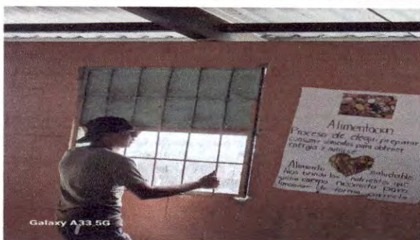
Foto 3: VENTANAS: Mantenimiento de balcones de metal de aulas 40m2.
