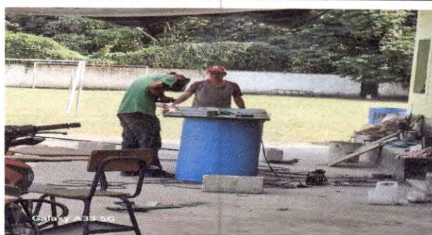
Foto 10: Puerta: Fabricación e instalación de puerta del campo de futbol
